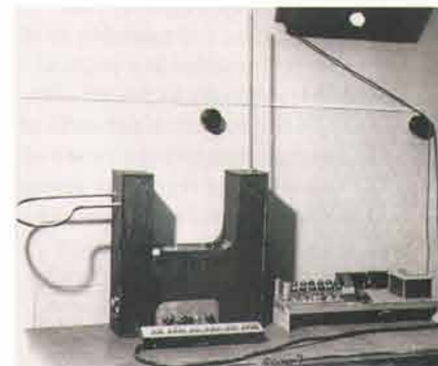
Instrument pour thérémine permettant de mesurer la hauteur de la note jouée / "Pitch visualizer" for the Theremin Theremin Centre Archive, Moscou / Moscow
